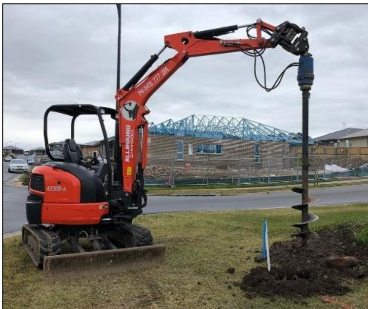
Рис. 1. Мини экскаватор с буровым оборудованием [2]
